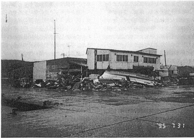
写真-3 奥尻漁協冷蔵庫。きわめて頑丈な造りで、内部の電源関係は浸水等の影響を受けたようであるが、本体は完全に生き残り、漁船3隻を押しとどめる効果があった。
