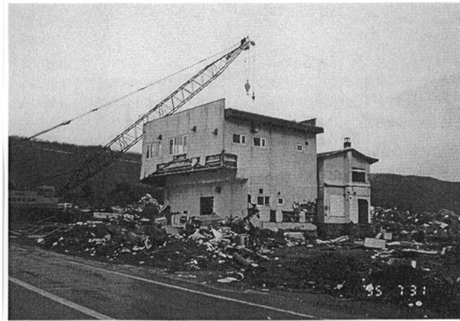
写真-5 青苗2区にある奥尻農協（左）と民家。農協は鉄骨組にコンクリート・パネル貼り、民家はブロック造である。
