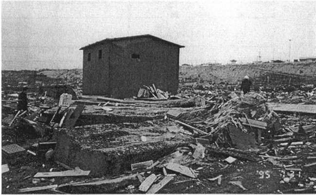
写真-2 青苗2区の西本商店土蔵。昭和初期に建設された。西側にある鉄の扉は水圧で変形し、高いところにある窓は破れたが、本体は完全に生き残り、中の物資も僅かな冠水に終わった。
