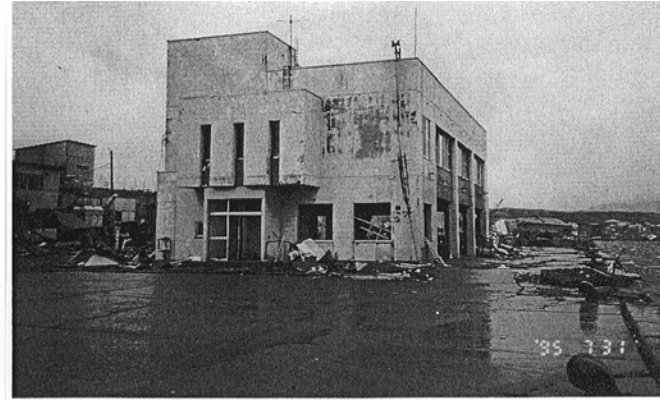
写真-4 青苗魚市場。一階の叩き部分は東西に吹き通しの腰高の建物で、南には部屋、北側はブロック壁となっていた。二階は事務所である。一階の部屋の窓は壊され、北側のブロック壁は外側へ倒されたが、そのほかは無傷で、二階は捜索隊によって使用されていた。
