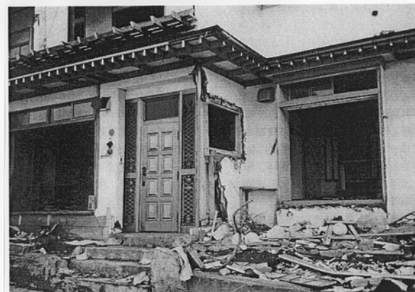
写真-9(4) 鎌田家の道路に面した部分。ガラス障子は吹き飛ばされたが、ドアは残った。
